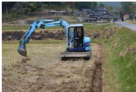
バックホーを用いた明渠設置作業
